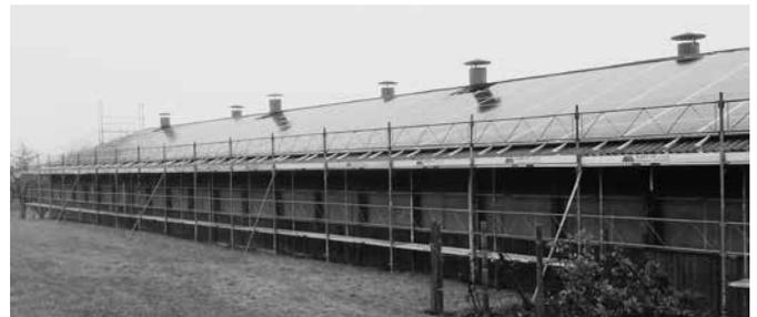
Die neue Anlage der Solargenossenschaft befindet sich auf dem Dach des Trutenstalls der Familie Lämmli in Heiligenschwil, Niederglatt. Momentan ist das südwestliche Dach mit PV-Modulen eingekleidet. In einem zweiten Schritt ist geplant, auch das nordöstliche Dach zur Stromproduktion zu nutzen. Die gesamte Anlage hätte dann eine Leistung von 130 kWp und würde somit Strom für rund 30 Durchschnittshaushalte liefern.
