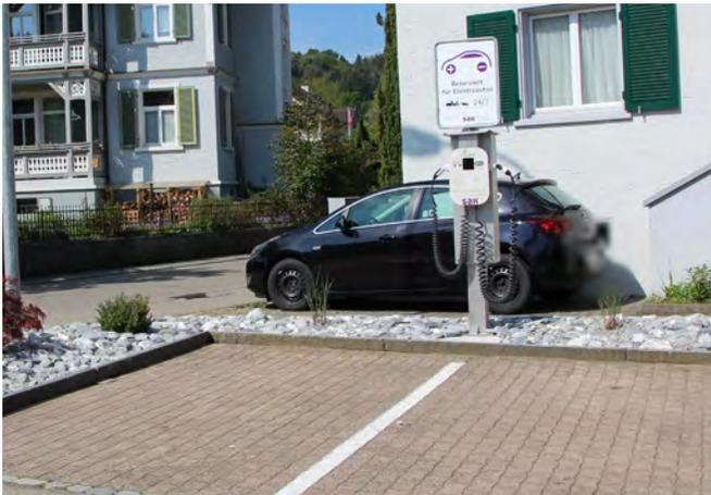
Elektrofahrzeuge sind energieeffizient und umweltschonend – sofern sie mit Naturstrom betrieben werden. Auf dem Rössli-Parkplatz im Dorfczentrum von Oberuzwil wurde vor kurzem die erste öffentliche Ladestation für Elektrofahrzeuge installiert. Sie wird mit Naturstrom gespeist und ist mit einer Leistung von 22 kW ausgestattet. Neben allen Typen von E-Autos können auch E-Bikes und E-Roller mit ihrem eigenen Ladegerät an der Station «aufgetankt» werden.
