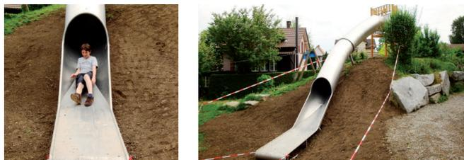
Die alte Kunststoffrutschbahn auf dem Spielplatz beim Feuerwehrdepot musste ersetzt werden. Sie wich einer Tunnelrutsche aus Chromstahl. Da die Rutschbahn auf einem Hügel positioniert ist, gelten spezielle Anforderungen an die Sicherheit. Um die vorgeschriebenen Fall- und Freibereiche einhalten zu können, musste der obere Teil der Rutsche mit einem Tunnel versehen werden. Dieses Element trägt einerseits zur Sicherheit bei, andererseits erhöht es auch den Spassfaktor bei den Kindern.
