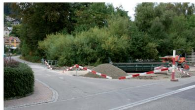
Beim Arvenweg standen ebenfalls Tiefbauarbeiten an. Durch die entsprechenden Werke wurden diverse Leitungen ersetzt. Die Gemeinde hat bei dieser Gelegenheit zusammen mit den Grundeigentümern den Strassenbelag und die Randabschlüsse erneuert.
