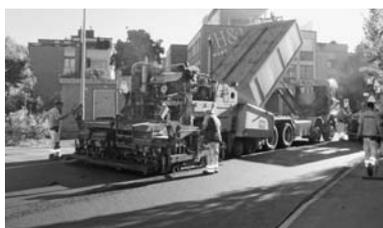
Auf der Lindengartenstrasse mussten Unebenheiten beseitigt und teilweise die Randabschlüsse erneuert werden. Zudem wurden die Einlenker der Hohrain- und der Schlattrainstrasse angepasst, sodass ein durchgängiges Trottoir entstand.
